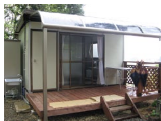
共同開発先との直流ハウス実証施設
