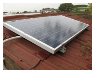
作業小屋の電源確保に
